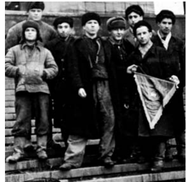
Рабочие, восстанавливающие здание театра в 1957 г.
