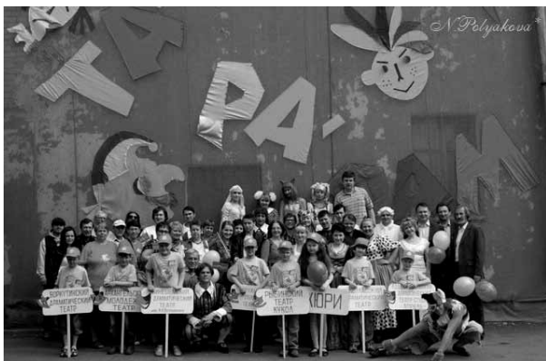
Участники фестиваля на фоне разрушающейся стены театра, затянутой сеткой
